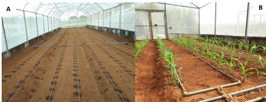
Figura 5. (A) Sistema de irrigação localizada por gotejamento instalado e operando na área experimental e (B) detalhe do controle das parcelas. Fonte: ARAÚJO, A. L. G. (2015).
